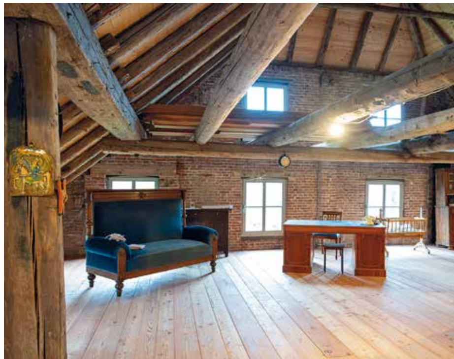
Oben: In der Diele haben antike Eichenmöbel einer Emder Kaufmannsfamilie einen neuen Platz gefunden. Ein Pelletofen beheizt das Haus. Unten: Der Fußboden auf dem Kornspeicher war nicht mehr zu retten und musste neu. Die Lärchendielen sind mit natürlichem Seegras gedämmt. Noch ist der imposante Raum mit seinen dicken Sichtbalken ungenutzt. Früher lagerte hier „das Gold des Bauern“, das Getreide. Damit das Gesinde keinen Zugang dazu hatte, war die Tür in der Brandmauer von innen fest verschlossen.
